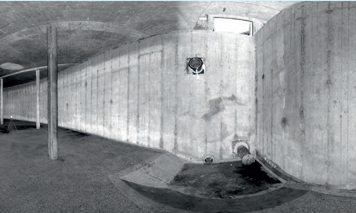
Bild 3 Rohbau: Das Innere einer Wasserkammer
